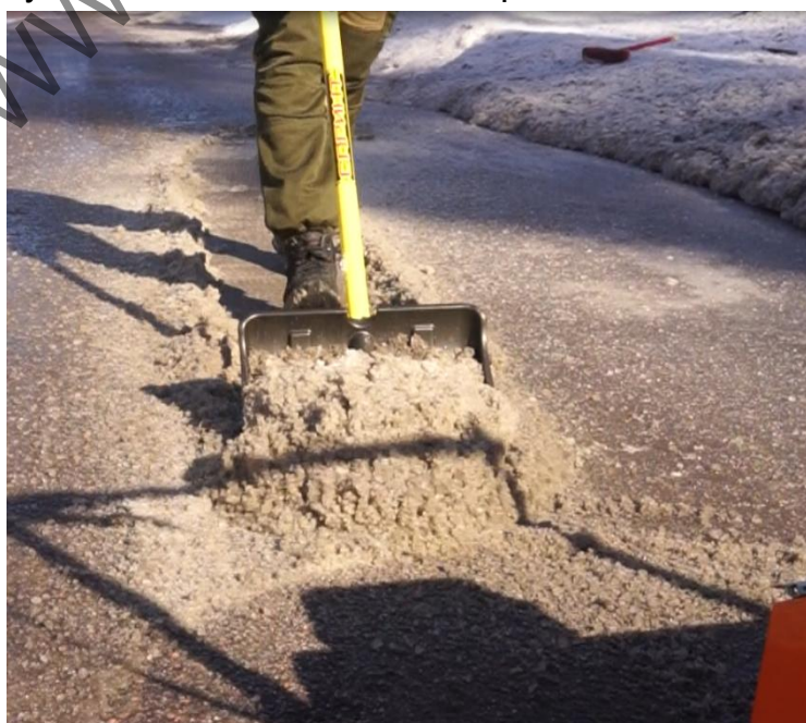
Рис.7. Очистка поверхности от ледяной крошки.
